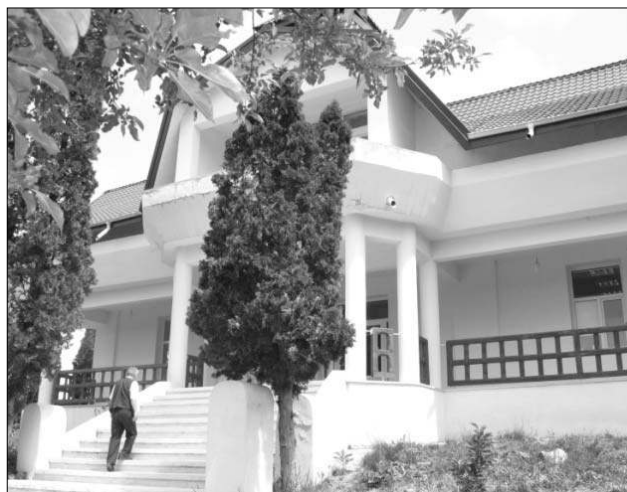
Casa familiei Inculeț de la Bîrnova. În această casă, restaurată și extinsă, funcționează astăzi Centrul multifuncțional de prevenire a abandonului școlar și a excluziunii sociale
